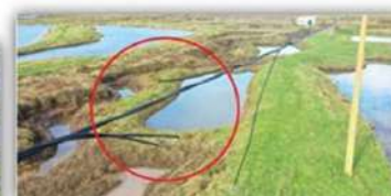
Détection de câbles sectionnés dans un marais
